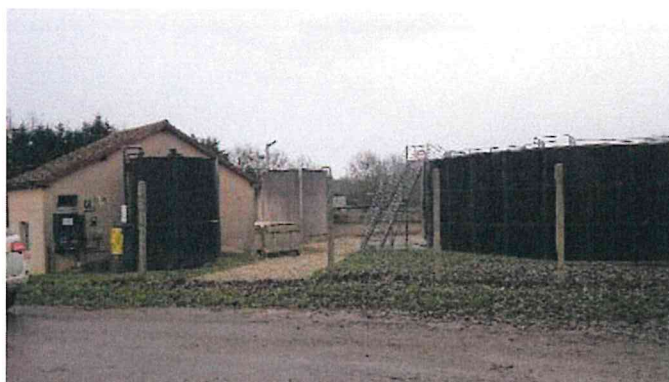
Figure 43 : Station d'épuration de Chailley
