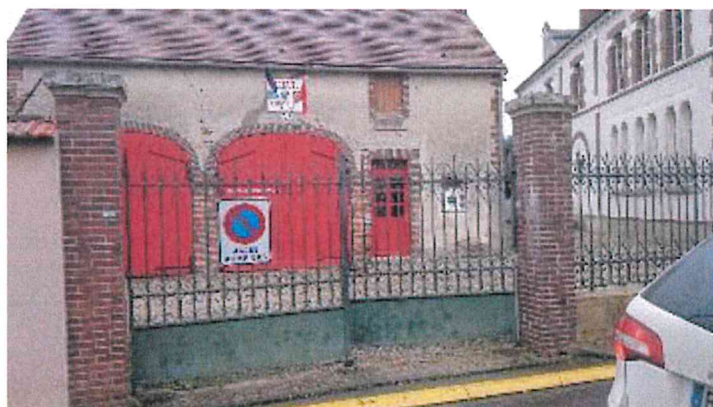
Figure 44 : Centre de protection incendie
